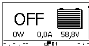
Fig. 7: Affichage après l'enclenchement du fusible externe de la batterie
